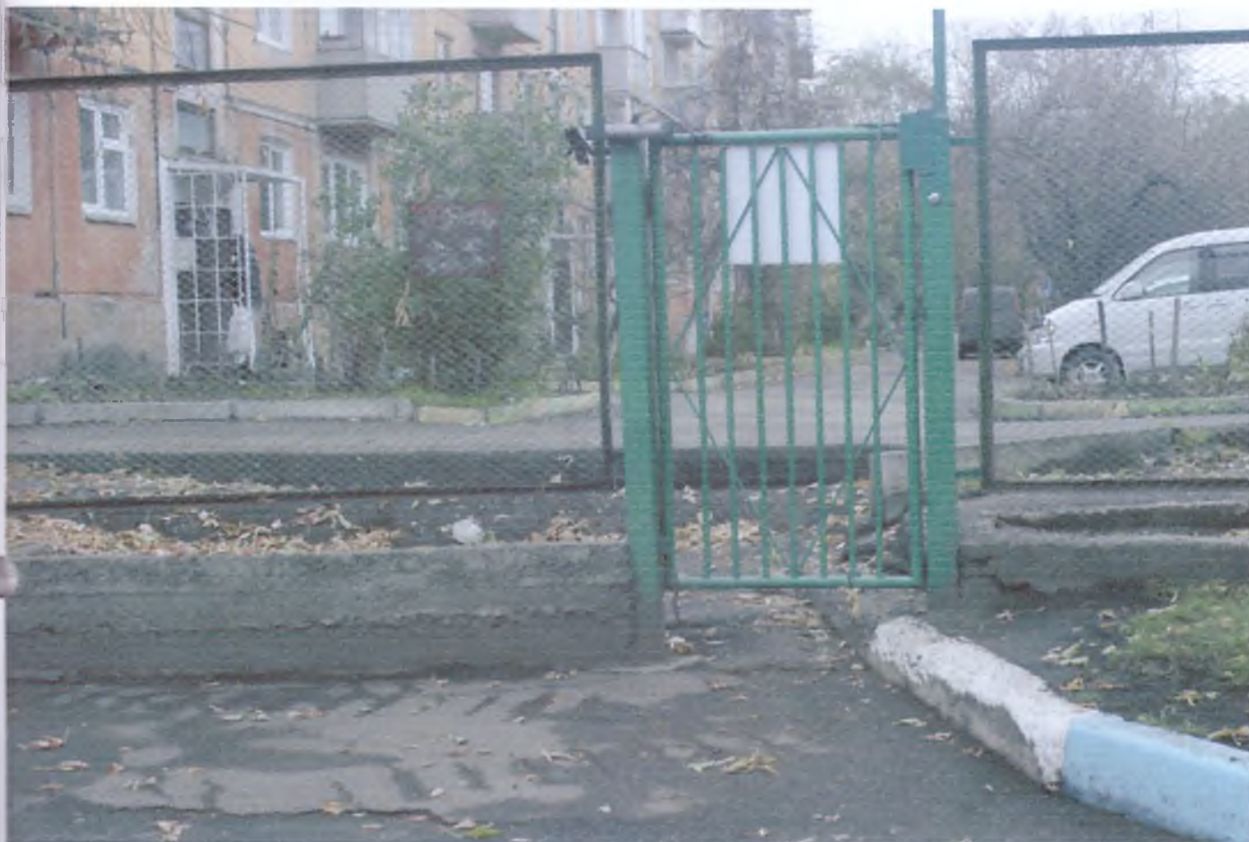
Вход на территорию объекта (фото № 1)
