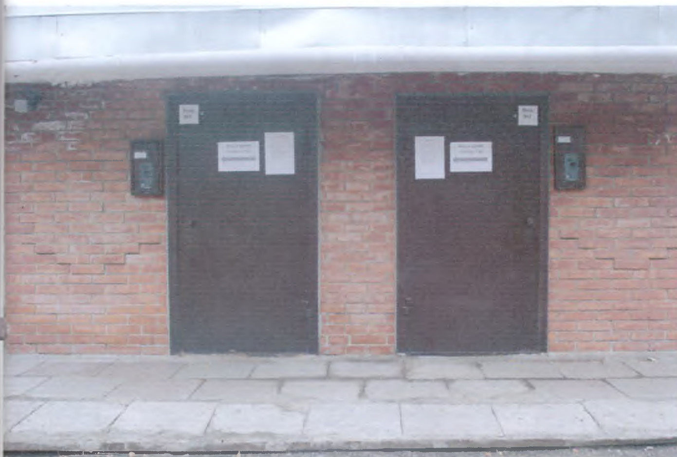
Вход в левое крыло здания (фото №3)
