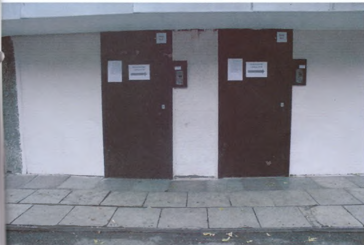
Вход в правое крыло здания (фото №4)
